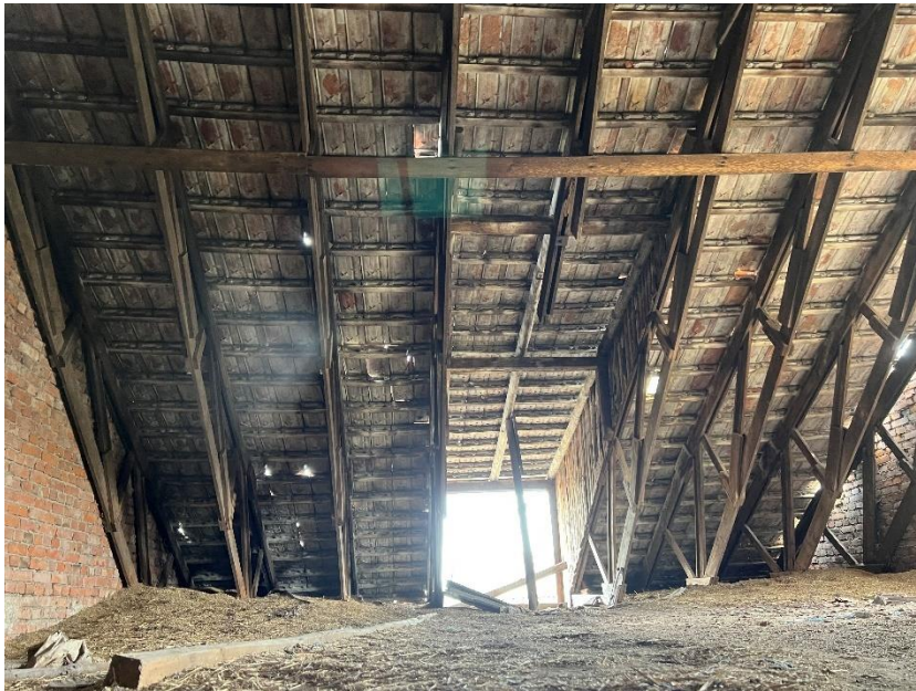
Abb. 27: Dachstuhl des östlichen Stallgebäudes
