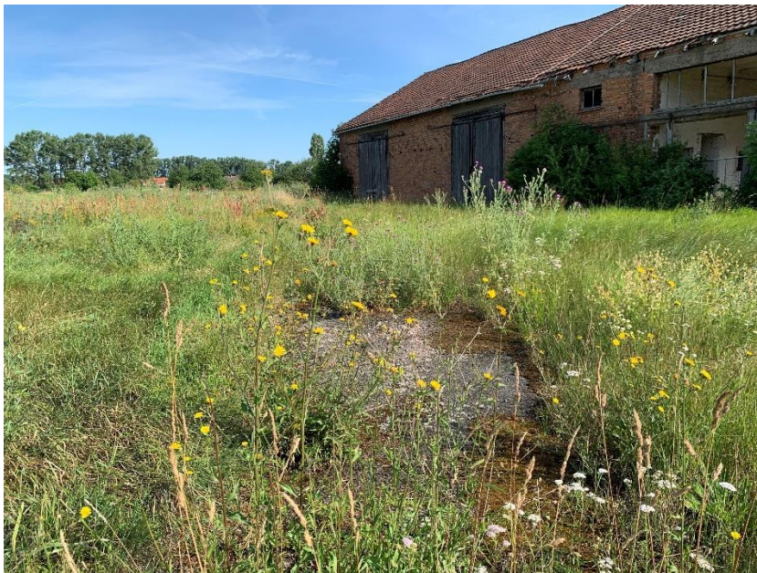
Abb. 22: teils überwachsene Betonflächen südlich der Stallgebäude
